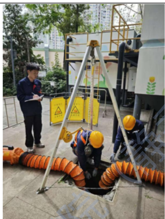
作业前通风及有害气体检测井口中段
