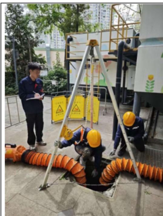
作业前通风及有害气体检测井口上段
