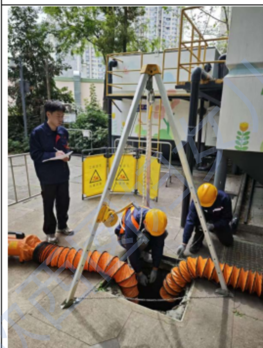
作业前通风及有害气体检测井口下段
